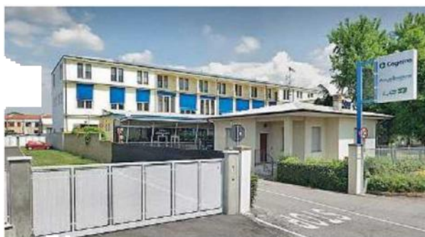
Acque Bresciane. A Rovato la sede amministrativa della società
