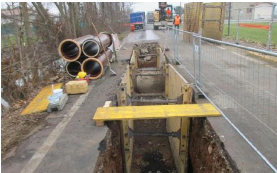
Il cantiere di Acque Bresciane: l'intervento è iniziato dalla frazione Duomo di Rovato
