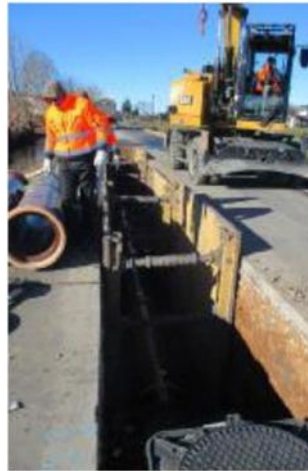
Il cantiere aperto a Rovato
