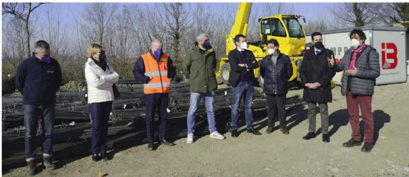
L'inaugurazione dei lavori giovedì mattina, alla presenza di tutte le autorità del territorio e di Acque Bresciane
