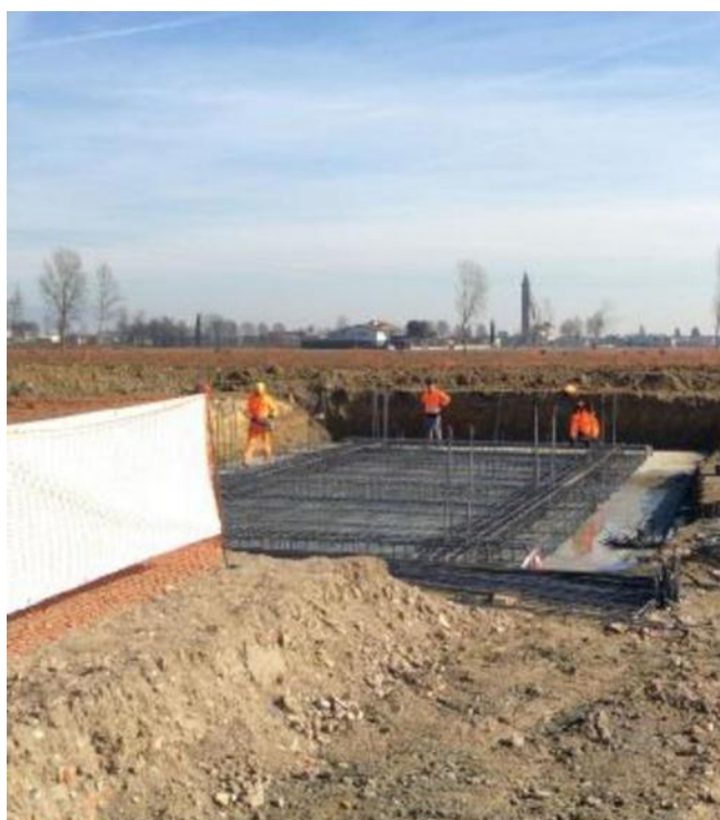
I lavori per la costruzione del depuratore consorsiale di Mairano
