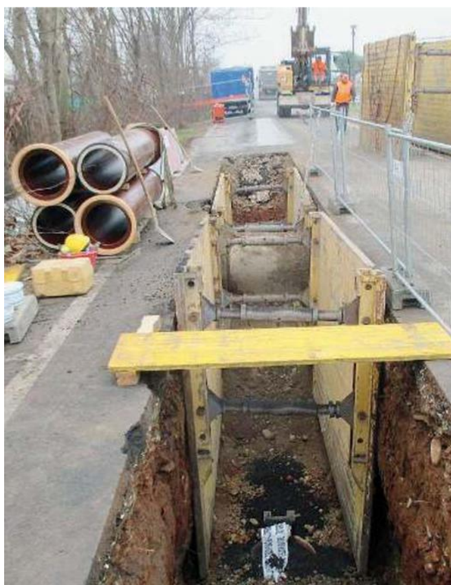
Cantiere aperto. Iniziati gli interventi per ampliare la rete fognaria
